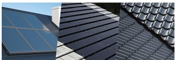
Des solutions de panneaux solaires peuvent être installés sur les toitures EUROMAC2 à l'aide des différents systèmes disponibles sur le marché (panneaux montés sur tuiles, panneaux intégrés, tuiles solaires, etc.). Nos toitures sont conçues pour être compatibles avec une majorité de solutions.
